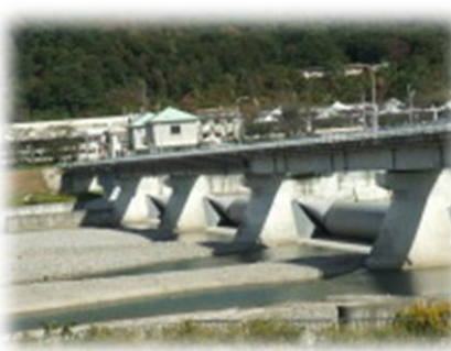
国道1号線・石部付近から野洲川を見ると頭首工があります
